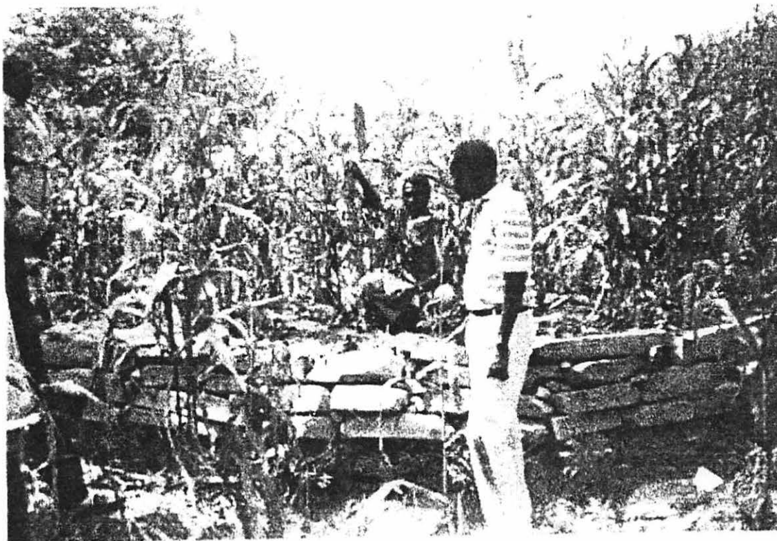
Figure 1: Barrage en pierres sèches dans la région de CARE (Passe Catabois).
